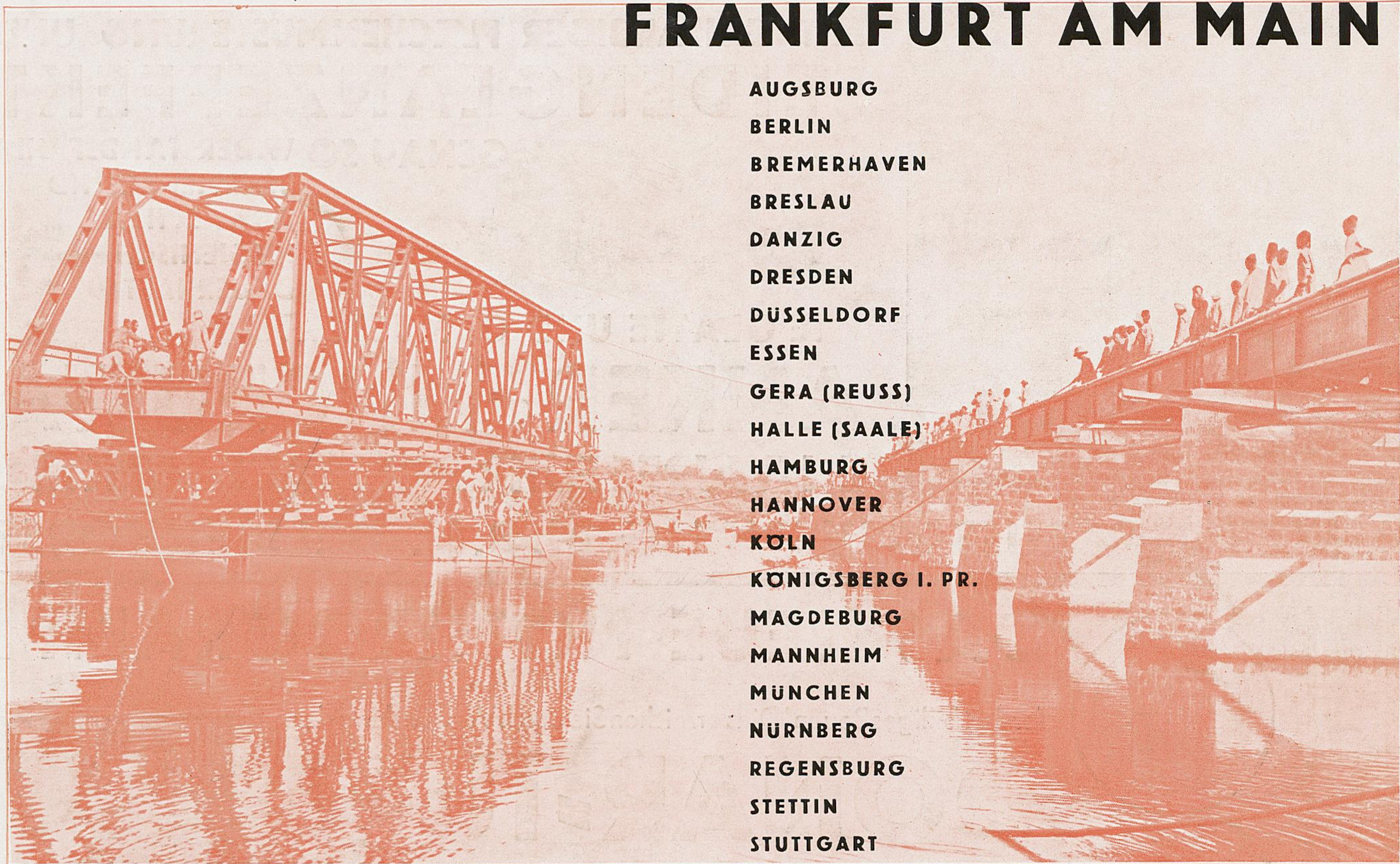
MALAGARASSIBRÜCKE DER MITTELLANDBAHN, OSTAFRIKA · EINSCHWIMMEN DER HAUPTÖFFNUNG.
